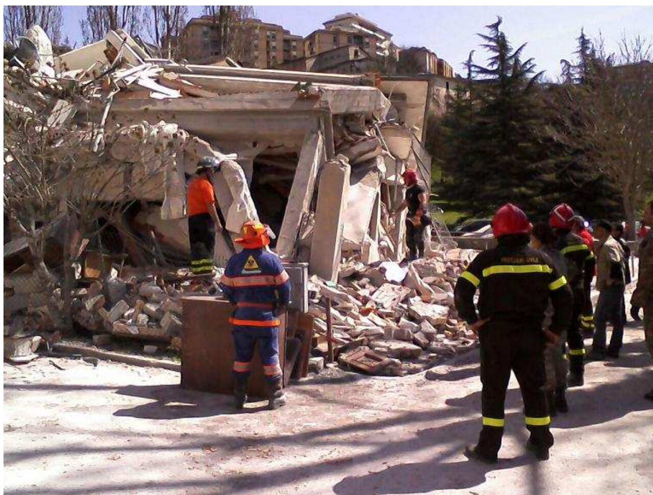
Intervento palazzina di 5 piani al centro dell'Aquila
